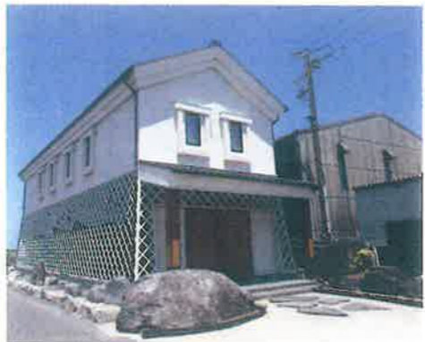
本社内には蔵や危機管理棟を建て、災害に備える
